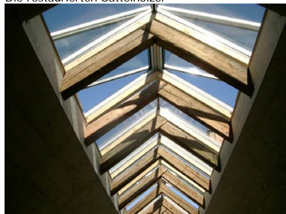
Oberlicht im Dachgeschoss; die bestehende Tragkonstruktion wurde belassen.
