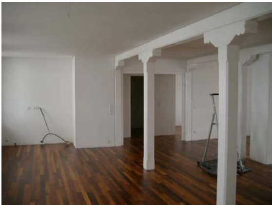
Die fertige Einheit mit Unterzügen und Stützenreihe
