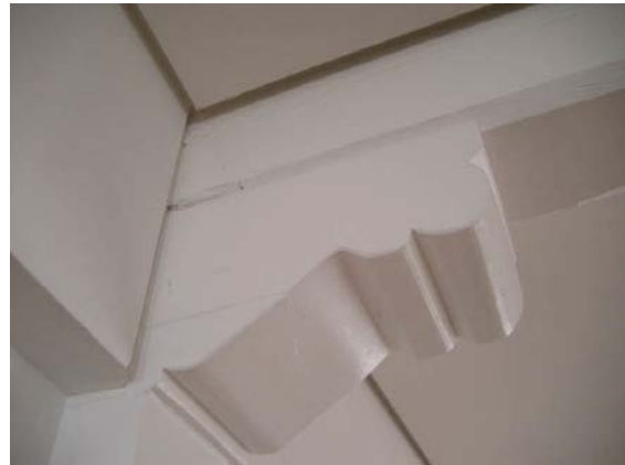
Die restaurierten Sattelhölzer
