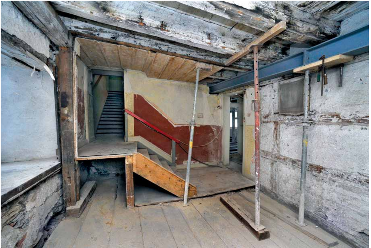
Abb. 4: Raum 1.10: Höhenunterschiede im 1. Obergeschoss.
