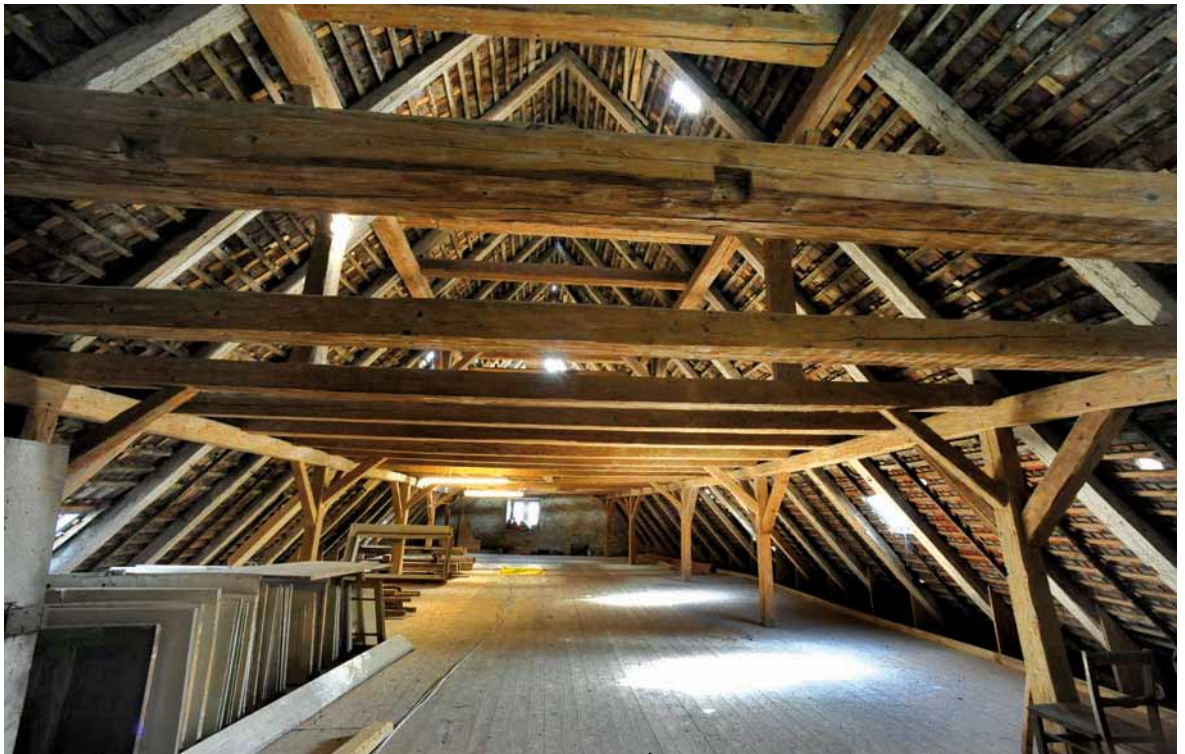
Abb. 18: Dachstuhl während der Sanierung.
