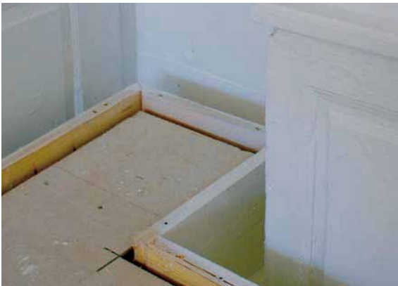
Abb. 14: Abstand vom neuen Fußboden zur alten Wandvertäferung.
