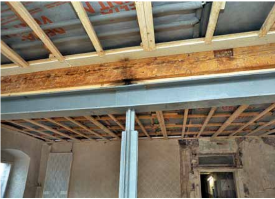
Abb. 10: Stahlträger im Saal und die sichtbaren Spuren der vor Ort zusammenschweißten Trägerelemente.
