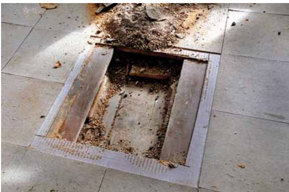
Abb. 11: Raum 2.01: Sondageöffnung im Bodenbelag.
