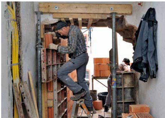
Abb. 7: Durchbruch der Außenmauer für den neuen Anbau des Fabrstuhls.
