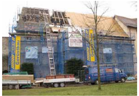
Abb. 19: Blick auf die Nordfassade während der Bauarbeiten.
