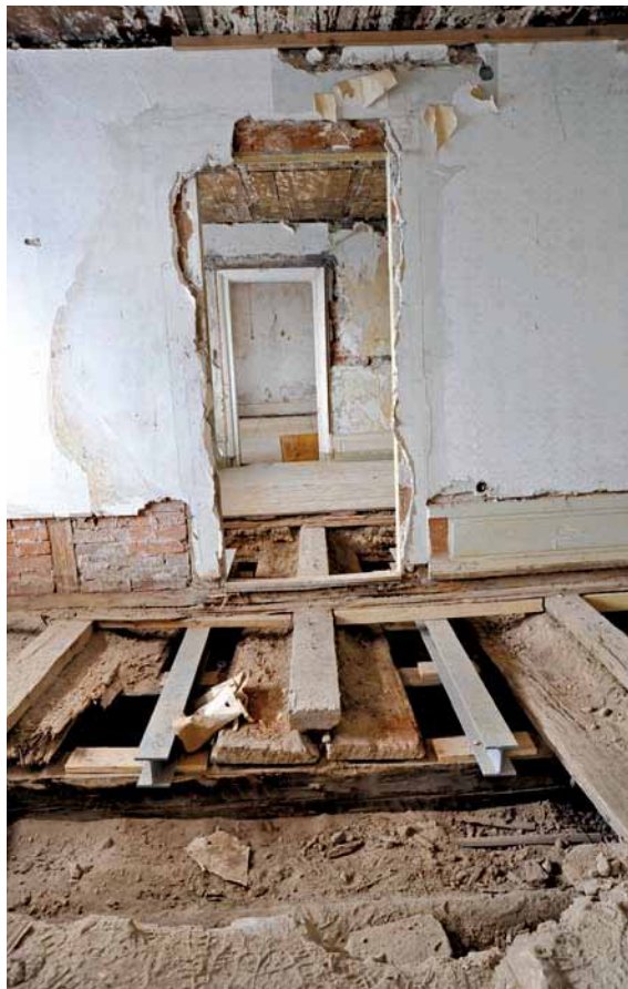
Abb. 3: Durchblick durch die freigelegten, südlich gelegenen Räume im 2. Obergeschoss.
