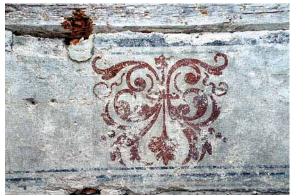
Abb. 2: Raum 1.17: Fachwerkkonstruktion mit aufwändigen Dekorationsbemalungen aus dem 16. Jahrhundert.
