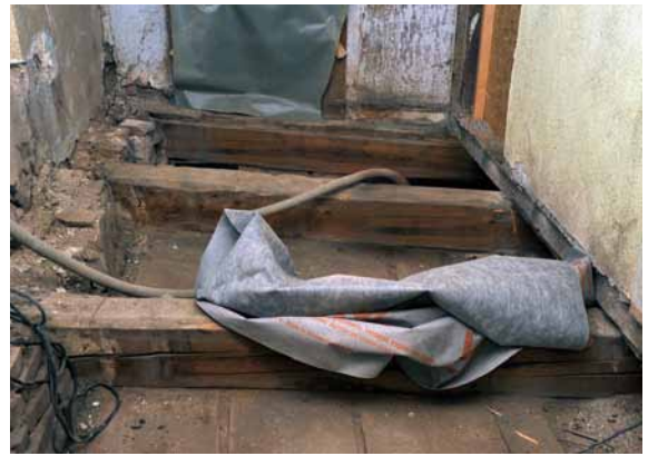
Abb. 12: Flurbereich im 2. Obergeschoss: Entkernung des Fußbodens.
