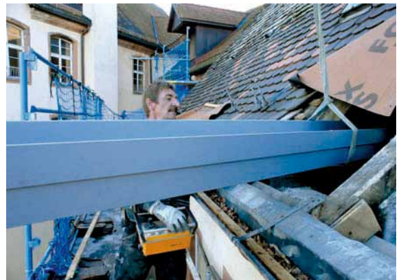
Abb. 9: Einbringen der Stahlträger über den Dachstuhl.
