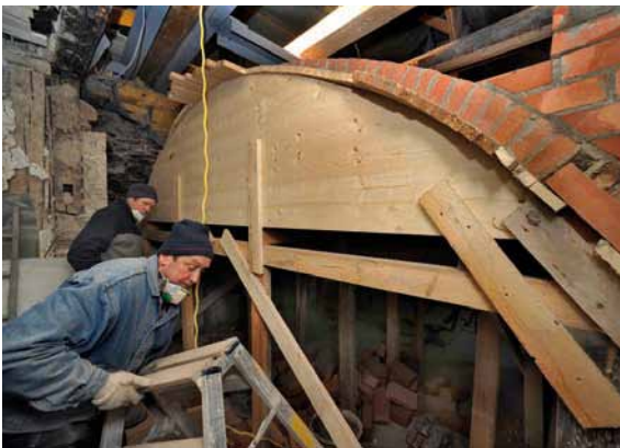
Abb. 15: Restaurierung und Nachbau des Gewölbes.
