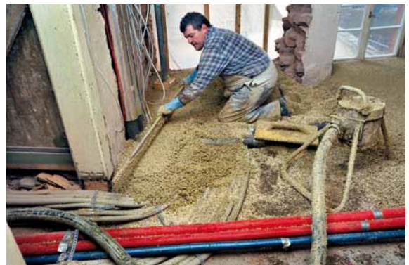
Abb. 13: Flurbereich im 1. Obergeschoss: Einbringen der Schüttung auf die verlegten Rohrleitungen.
