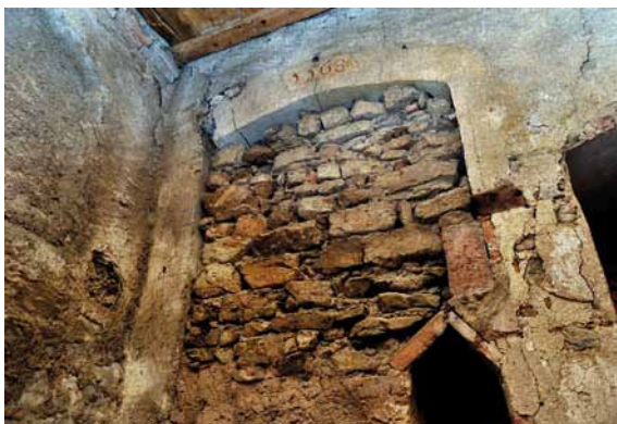
Abb. 1: Umbaumaßnahmen im Lauf der Zeit: Blick auf den im Jahre 1568 zwischen Alt- und Anbau ausgebrochenen Durchgang im Keller des Gebäudes.
