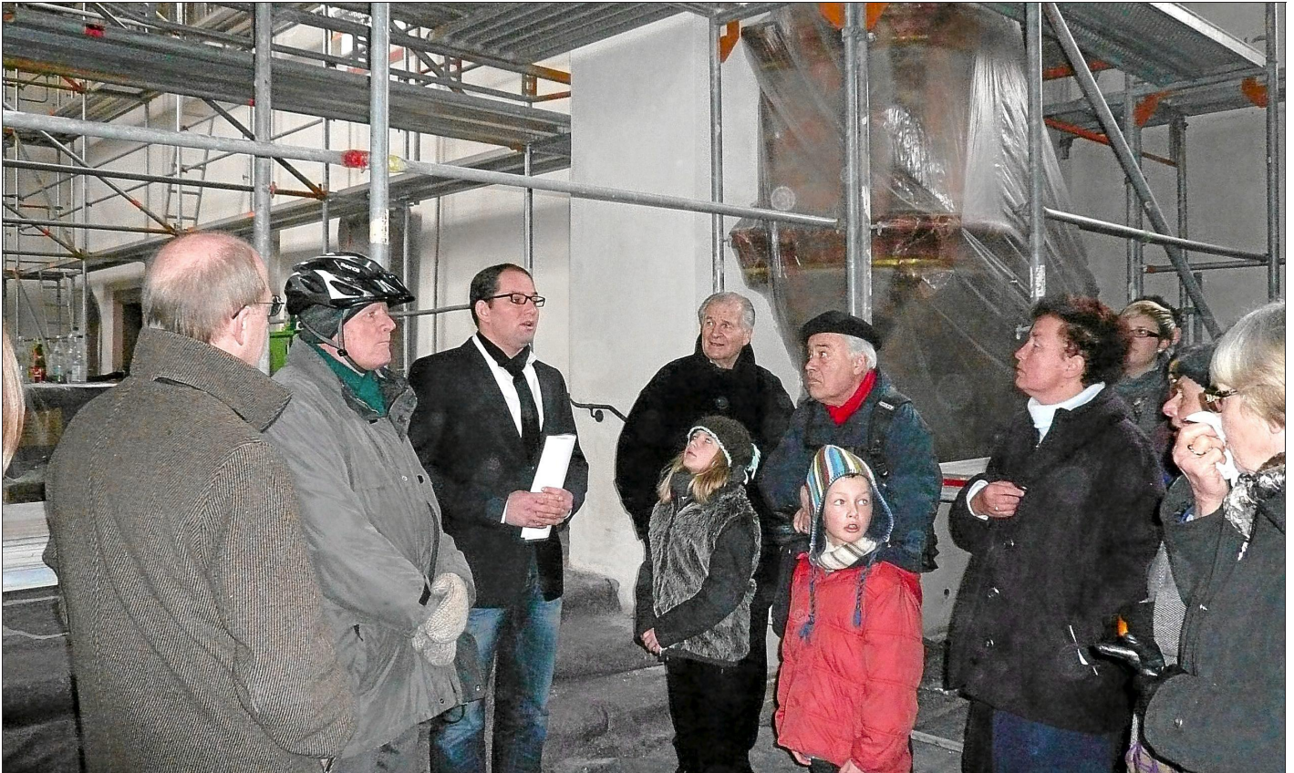
Architekt Andreas Flöß (Dritter von links) erläuterte bei einem Rundgang durch die Sanierungsbaustelle Villingener Johanneskirche den Sachstand der Renovierungsarbeiten. Foto: Winkelmann-Klingsporn
