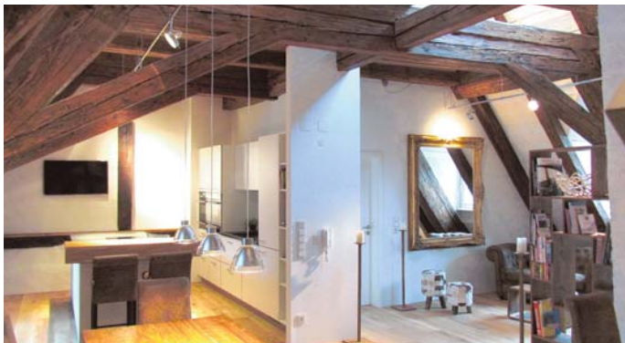
Das aus der Barockzeit stammenden Dachgebälk wurde vollkommen freigelegt und sorgt für die besondere Atmosphäre in der Wohnung.
