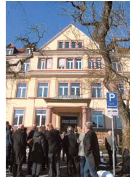
Die Mitglieder des Kreistagsausschusses sehen sich den Zustand des alten Internatsgebäude vor Ort an. BILD: DREHER
