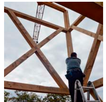
Nach und nach entsteht der neue Turm in Zimmermannsbauweise. BILD: FLÖSS
