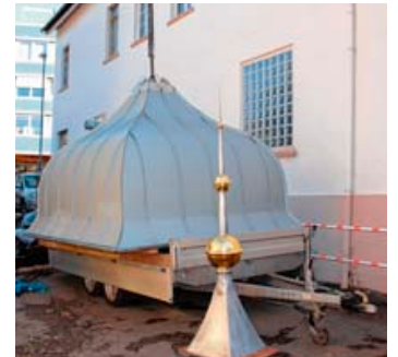
Noch am Boden: Kuppel und Turmspitze für das Haus in der Luisenstraße.
