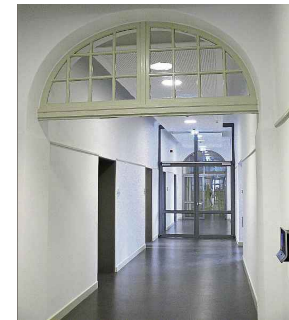
Einige Kilometer Kabel und sonstige Versorgungsleitungen wurden während der Sanierung verlegt. Vieles wurde in den abgehängten Decken in den Fluren verbaut. Foto: Strohmeier
