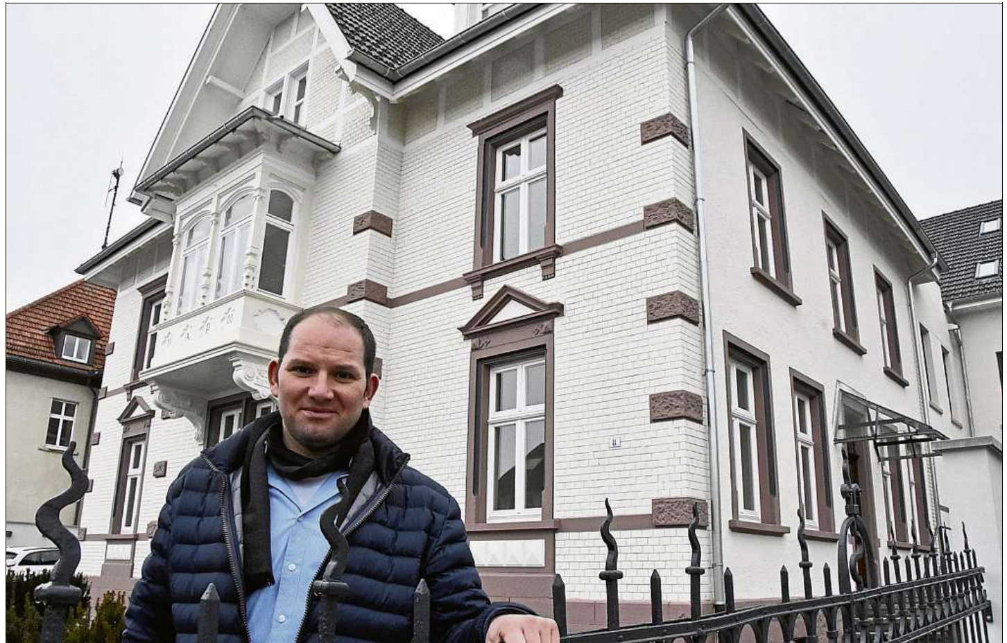
Architekt Andreas Flöß vor der Jugendstil-Villa in der Bahnhofstraße. Ab März sollen in der Preiser-Villa, die dann »Hotel Villa 8« heißen wird, Gäste schlafen. Fotos: Spitz
