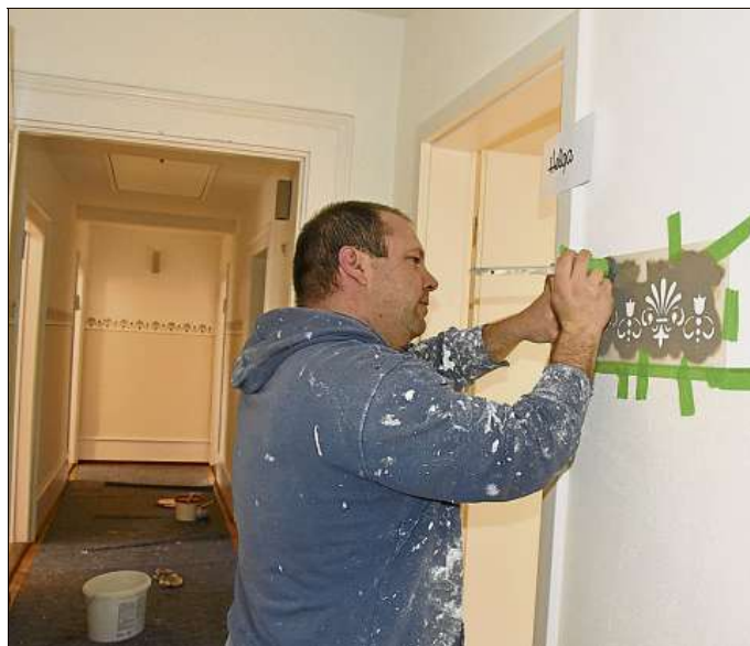
Arbeit im Detail: Roland Heini vom Malerbetrieb Malinowski bringt von Hand die Bordüre an, die den kompletten Flur der Villa durchzieht.
