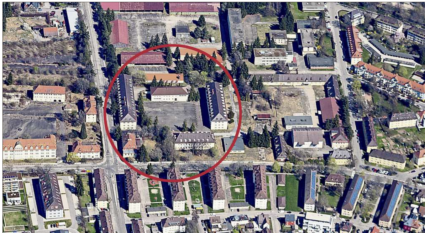
Auf einem Teil des Mangin-Areals in Villingen (durch Kreis gekennzeichnet) werden Ämter der Stadt untergebracht.
