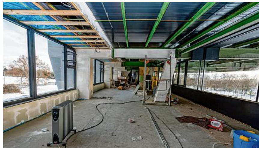
Der Rohbau ist fast fertig, jetzt geht es an den Innenausbau des neuen Lounge-Bereichs. Alles soll aber offen, hell und transparent werden, mit weiten Ausblicken nach allen Seiten.
