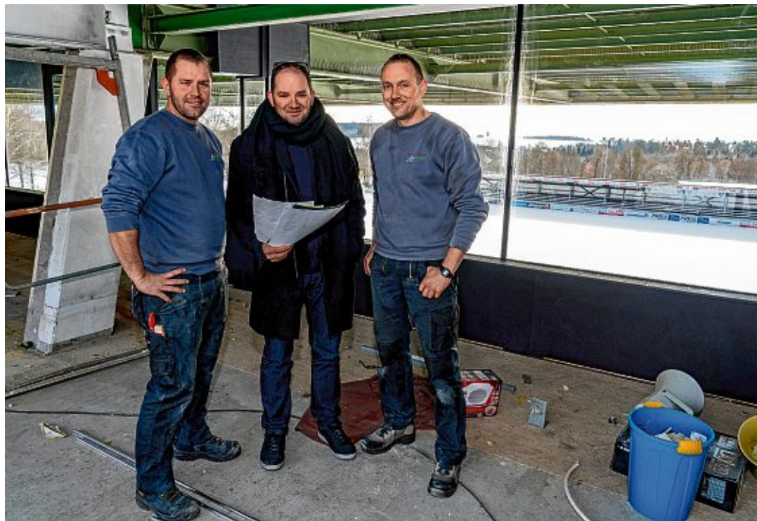
Architekt Andreas Flöß (Mitte) bespricht mit den Handwerkern Michael Fleig (links) und Oliver Obergföll (rechts) die Planungen für den anstehenden Innenausbau des VIP-Bereichs. BILDER: HANS-JÜRGEN GÖTZ
