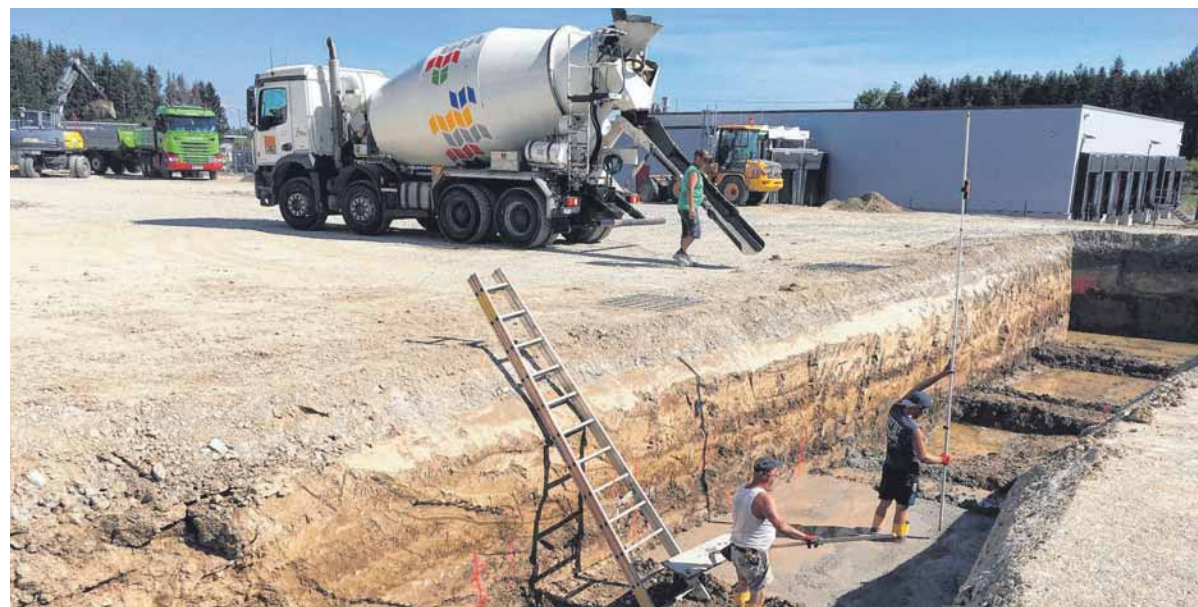
Die Erdarbeiten für die Erweiterung haben bereits begonnen.
