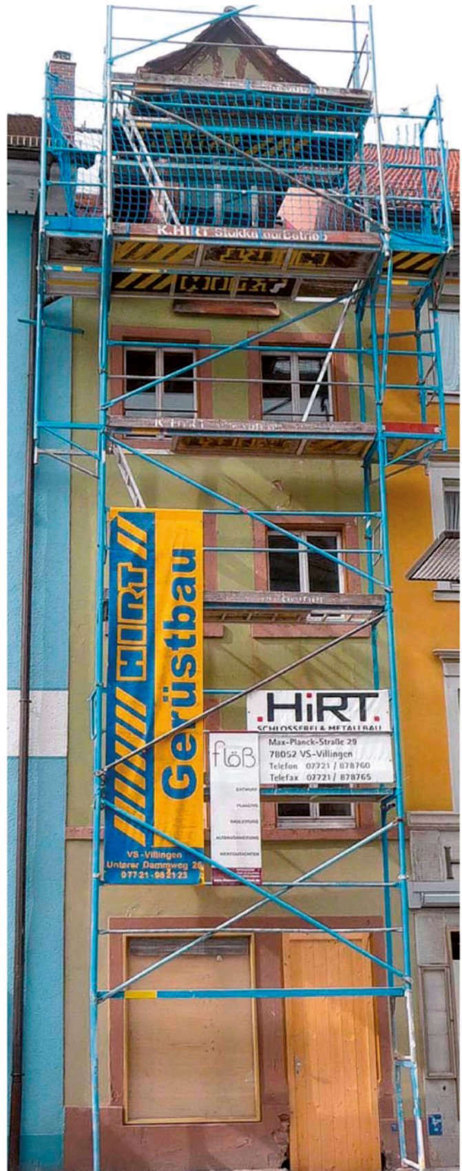
Das schmalste Haus der Stadt, Bickenstraße 3, ist gerade mal 2,80 Meter breit. Architekt Andreas Flöß baut hier eine Wohnung über fünf Stockwerke aus, macht alte Bausubstanz wieder sichtbar und die Baugeschichte erlebbar. BILDER: SCHUBERT
