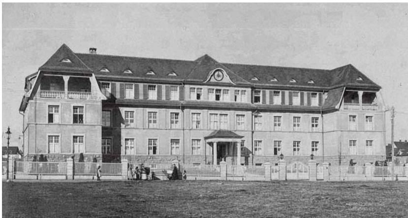
So sah das Villingen Krankenhaus, das 1911 in Betrieb genommen wurde, im Ursprung aus. In den 30er-Jahren folgten einige Anbauten. Auf den Balkonen links und rechts im dritten Geschoss konnten die Lungenpatienten die gute Luft genießen. BILD: STADTARCHIV VS
