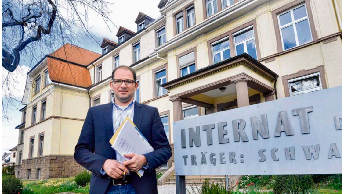
Dieses stolze Gebäude in der Herdstraße hat eine vielfältige Geschichte. Einst Villingen Krankenhaus, dann Internat der Hotelfachschule und demnächst Gesundheitsamt und Behördenzentrum des Landkreises. Architekt Andreas Flöß ist begeistert von der Bausubstanz des Hauses, das 1910/11 errichtet wurde. BILD: JOCHEN HAHNE
