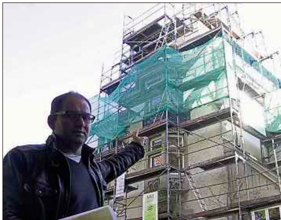
Architekt Andreas Flöß saniert das Haus Luisenstraße 4 in Villingen.
