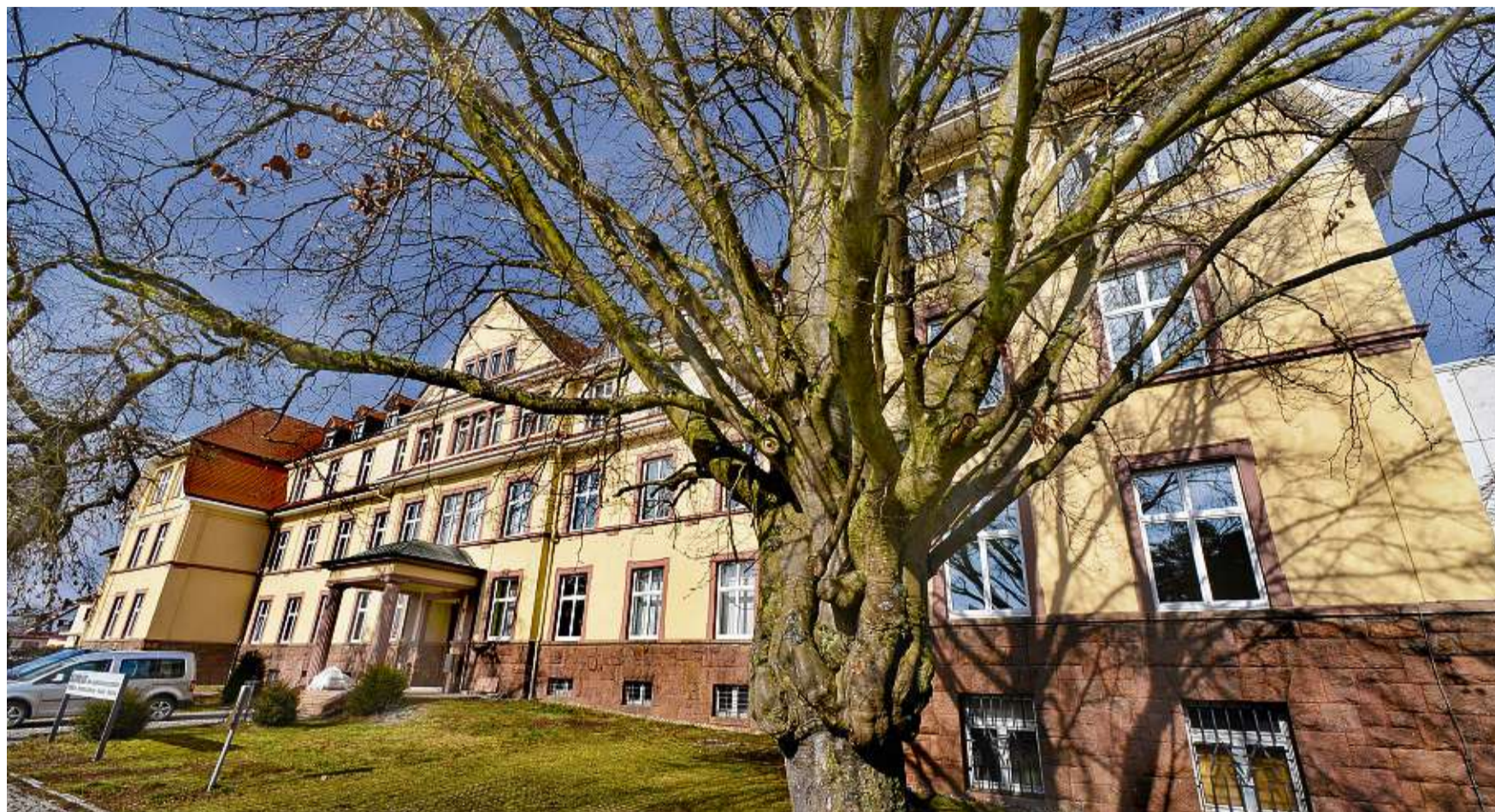
Komplett saniert wurde das Gebäude Herdstraße 4, das ehemalige Villingen Krankenhaus (1911-1961). BILDER: JOCHEN HAHNE
