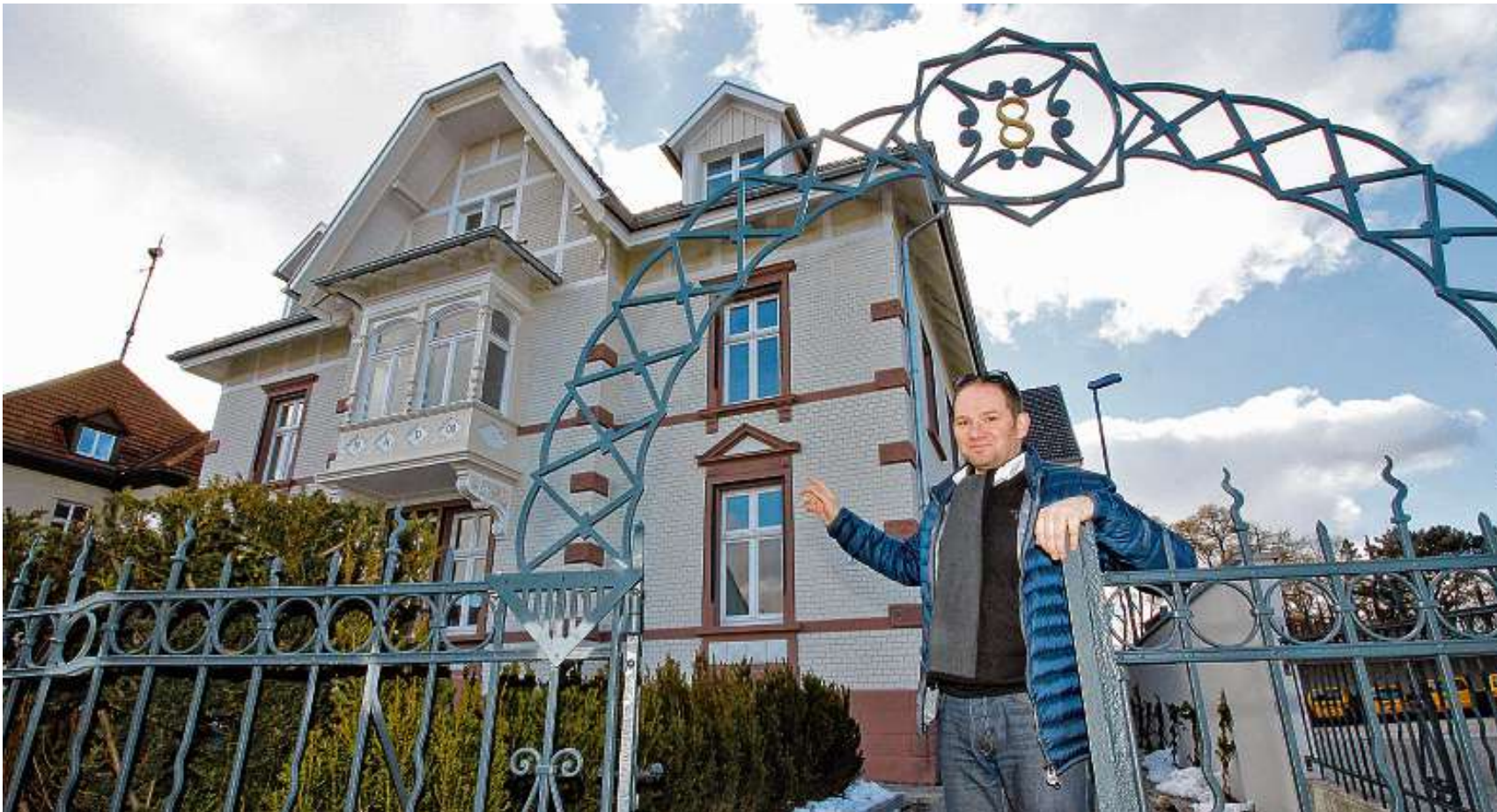
Andeas Flöß vor der „Villa 8“ in der Villingen Bahnhofstraße. Der Architekt hat die Jugendstilvilla in den vergangenen Monaten im Auftrag der neuen Besitzerin Brigitte Hiermaier zum Hotel umgestaltet. Die Betreiberin selbst will sich erst zum Start des Hotelbetriebs, voraussichtlich im März, vor die Kamera stellen. BILD: JENS FRÖHLICH
