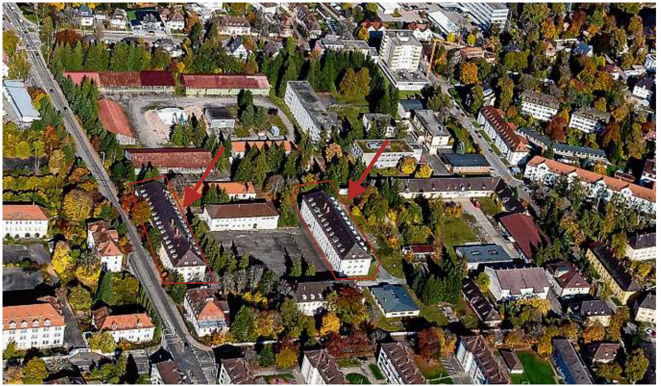
Die beiden mit rotem Pfeil gekennzeichneten Gebäude sind die ehemaligen Mannschaftsgebäude auf dem früheren Kasernengelände Mangin. Für 41 Millionen Euro sollen sie als Verwaltungssitz umgebaut werden und Platz für 342 Mitarbeiter bieten. LUFTBILD: HANS-JÜRGEN GÖTZ
