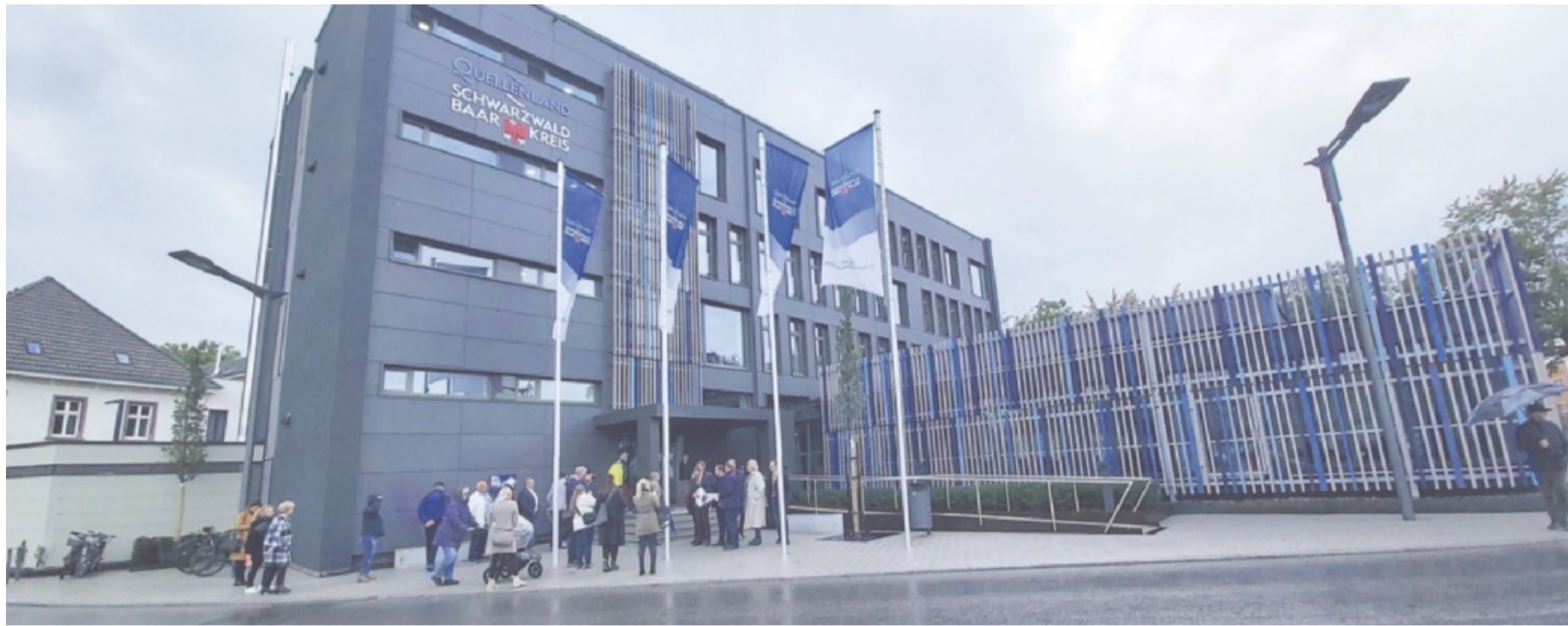
Im neuen Verwaltungsgebäude des Landratsamtes Schwarzwald-Baar in Villingen sind das Amt für Abfallwirtschaft, die Bußgeldbehörde, das Kreisarchiv und das Kreisjugendamt untergebracht. Fotos: Cornelia Hellweg
