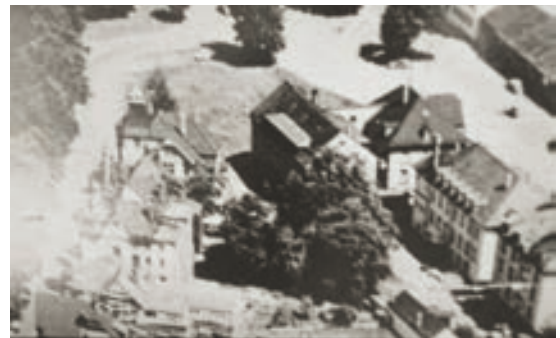
Abb. 3: undatiertes Luftbild, im Norden links, das heute noch existierende Haus Luisenstraße 4 mit Turm sowie rechts die Preiser Schnapsfabrik nebst vorgelagertem Wohnhaus in der Bahnhofstraße 8. Im obersten Bildabschnitt die Wiese mit den bereits abgebrochenen Häusern Bahnhofstraße 2 und 6 sowie den ebenfalls fehlenden Häusern Luisenstraße 2 und 3.
